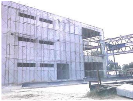
Fig. 2 TMEC Construction site (August 99)
